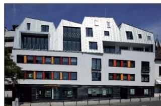
Kaum wieder zu erkennen: Das Gebäude vor, während und nach dem Umbau. Die massiven Untergeschosse aus den 1950er Jahren erhielten eine Aufstockung in Holzleichtbauweise mit markant geformtem Titanzinkdach.
