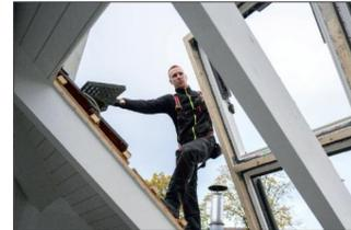
Er diente als Maßstab für die weiteren Arbeiten, denn basierend auf seiner Größe wurde der Rahmen der Kassette aus Konstruktionsvollholz (KVH) passgenau von ZEP-Team gezimert und montiert. Auch die Montage des Eindeckrahmens erfolgte noch am Boden, was spätere, zeitaufwändige Arbeiten in Schräglage überflüssig machte.
