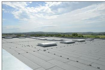
Flachdächer müssen in der Regel mit einem Gefälle ausgeführt werden, da stehendes Wasser Schäden verursachen kann. Bauder, führender Anbieter von Dachsystemen zum Dichten, Dämmen, Begrünen und Energie gewinnen, bietet hierfür die objekt- und auftragsbezogene Hochwertgefälledämmung BauderPIR T aus PU-Hartschaum in verschiedenen Dicken an. Das allerdings benötigt eine gewisse Lieferzeit.
