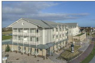
Design und Funktion bilden hier eine Symbiose auf sehr hohem Niveau. Die Ausstattungsanpassung der RIB-ROOF Metalldächer an die Inselumgebung erfolgte mit einer besonderen seewasserbeständigen Hochleistungsbeschichtung.
