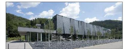
Die trapezförmigen Fassadenabschnitte sind in unterschiedlichen Winkeln leicht vertikal gekippt.
