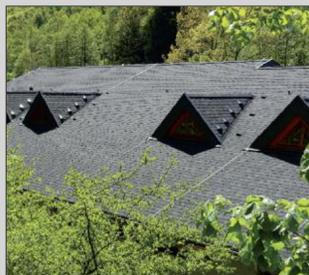
Zur Be- und Entlüftung wurden im First- und Gratbereich IKO Armourvent Multi Plus, in der Fläche IKO Armourvent Special, IKO Armourvent Standard und IKO Sanitary Plus eingesetzt. Die Ausführung erfolgte durch den Dachdeckerbetrieb Michael Platzten aus Weitefeld.
