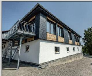
Aluminium-Elemente für intelligente und optisch ansprechende Lösungen von Gebäudefassaden. Das Beste beider Produkte vereint jetzt das Siding.X. Es bereichert die funktionellen und konstruktiv hervorragenden Lösungen der Sidings um die unverwechselbare, unregelmäßige sowie Lichteinfall und Umgebung widerspiegelnde Optik der Paneele. Das
