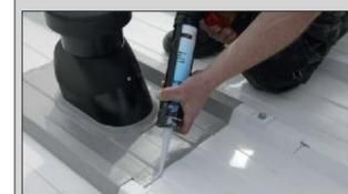
Anschlusschürze reduziert. Anschließend kann der Dachdecker die Stoffkante mit dem Dicht- und Montagekleber dauerhaft versiegeln.
