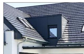
Die Autarq-Solarziegel sehen fast aus wie normale Creaton-Domino-Flachziegel. Solar- und Standard-Ziegel ermöglichen ein perfektes Zusammenspiel.
