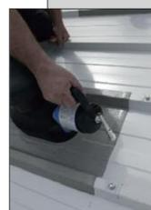
rolle passt der Verarbeiter die Manschette an die Profilierung des Sandwich-Elements an. Da die Manschette selbstklebend ist, ist eine zusätzliche mechanische Verschraubung auf der Metalloberfläche nicht erforderlich. Die Manschette besteht aus PIB mit selbstverschweißenden Eigenschaften. So kann sie gegebenenfalls mit Wakaflex-Anschlussband auch verlängert werden.
