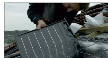
Mit einer Steckverbindung werden die Solarziegel parallel verschaltet wie eine elektrische Christbaumbeleuchtung.
