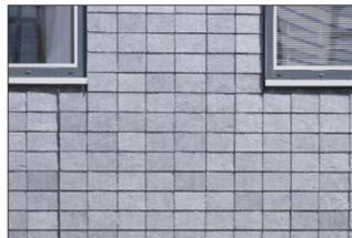
Ansicht der Variablen Schieferdeckung mit Kreuzfugen-Optik und einer Dehnungsfuge unter dem linken Fenster.
