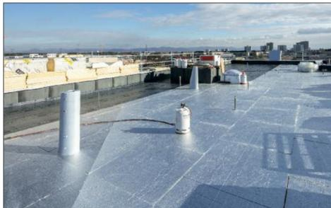
ser aufnimmt, käme es bei einer temporären Beschädigung der Dachhaut durch Fremdhandwerker weder zu einer Verschlechterung der Dämmwirkung, noch zu großflächigen Schäden.
