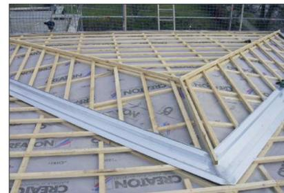
Bei modernen Dächern mit Dämmung kommen in der Regel diffusionsoffene Unterdeckbahnen zum Einsatz, um vor dem Eindringen von Regen, Feuchtigkeit und Flugschnee zu schützen.
