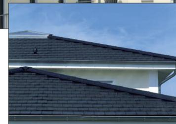
Der Glattziegel „Domino“ schafft eine einheitliche Fläche auf dem flach geneigten Dach und verleiht ihm einen modernen Ausdruck.
