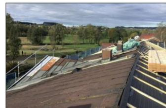
Bild oben: Während links noch Reste der alten Stahlbleche zu sehen sind, wird rechts mit der Vordeckbahn und Lattung bereits die zweite und zusätzliche Rauhspundschalung für die Hinterlüftung vorbereitet.
