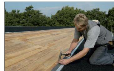
Die Lagesicherung durch Nagelung oder Klammerung erfolgt im überdeckten Bahnenrand, damit die Durchdringungsbereiche der Bahn anschließend überdeckt und durch den Butylstreifen abgedichtet werden.
