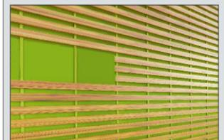
Die neue Bahn kann bei Fassadenbekleidungen mit bis zu 50 Millimeter breiten Fugen und einem Fugenanteil von 50 Prozent der Fläche eingesetzt werden.
