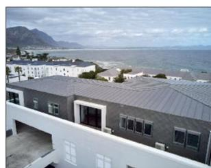
herrschenden Witterungseinflüsse. Das Dach im Doppelstehfalzsystem aus werkseitig vorbewittertem NedZink NOVA Bandmaterial 0,80 x 600 mm bietet eine klare Linienführung und unterstreicht den hochwertigen Charakter des Penthouse-Designs. Die verwinkelten Walmdachflächen sind durch Gratleisten voneinander getrennt und segmentiert - eine technisch und optisch einwandfreie Lösung. Das kühne Design ist völlig einzigartig für die Gegend und somit ein echter Blickfang.
