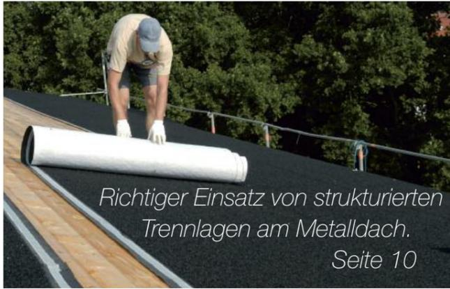
Richtiger Einsatz von strukturierten Trennlagen am Metaldach. Seite 10
