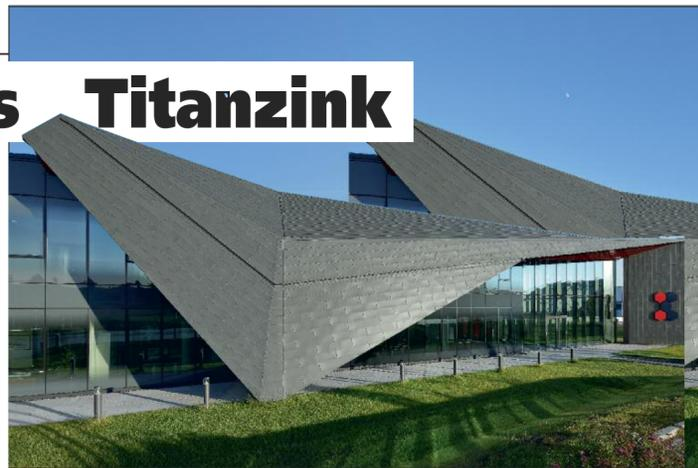
Peter Meinecke von SKAI. „Die Stahlkonstruktion des rund 44 m breiten und am höchsten Punkt knapp 9,50 m hohen Vordachs steht links am Fußpunkt sowie rechts auf einer Stahlbeton-Wandscheibe auf und ist oben am Gebäude befestigt. Das Stahltragwerk hat eine rechnerische Längenausdehnung infolge der Wärme von bis zu 3 cm, das Gebäude aber nur von 1 cm. Darum verläuft längs durch das gesamte Vordach und damit mitten in der Bekleidung eine Dehnfuge, die für alle Bauteilschichten zu übernehmen war.“
