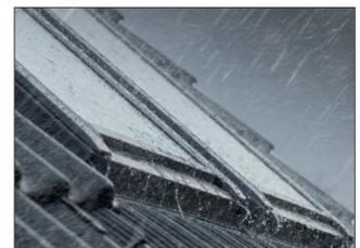
wortlich für den Gewinn an Wohnqualität ist ein geräuschdämmendes Material, mit dem die Fensterbleche hinterklebt sind, so dass das Geräusch der dort auftreffenden Regentropfen deutlich gedämpft wird.
