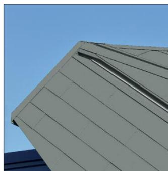
eingesetzt und anschließend mit Rauten oder je nach Situation auch Sonderprofilen aus Titanzink bekleidet wurde. Auch der große Wasserfangkasten im Zwickel wurde aus Aluminium geschweißt und im Ganzen eingesetzt. Zum Schutz gegen Vereisung im Winter sind sowohl der Wasserfangkasten als auch die Rinnen beheizt.
