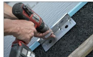
Die Lagesicherung der Schare erfolgt mit auf die Unterkonstruktion abgestimmten Haften.
