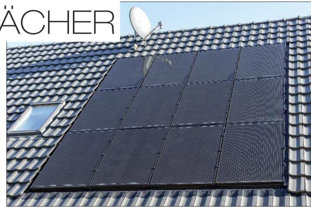
schwarzen PV-Module lassen sich komplett in das Dach integrieren und sorgen so für eine einheitliche ästhetische Dachoberfläche. Alle Komponenten sind optimal aufeinander abgestimmt und auch bei Reparaturen und Austausch leicht zugänglich. Die Fernaktualisierung der Systemsoftware, ein integriertes Energiemanagement und Monitoring in Echtzeit machen das System besonders kundenfreundlich.
