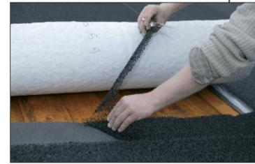
Für eine regensichere Verbindung des Kopfstoßes wird das Wirrgelege entfernt.
