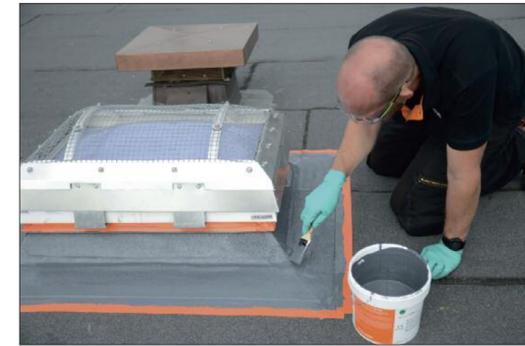
Das 1-komponentige BauderLIQUITEC PU Flüssigkunststoff-System ist thixotrop eingestellt, also speziell für eine optimale Verarbeitung an Details und Anschlüssen, entsprechend DIN 18531 und Flachdachrichtlinie, entwickelt. Es kann bei Untergrundtemperaturen von +5 bis +55°C verarbeitet werden und mit einem Verbrauch von ca. 3,1 kg/m<sup>2</sup> wird eine Trockenschichtdicke von 2,5 mm erreicht. Damit wird die Anforderung aus der Fachregel (2,1 mm) übertroffen.
