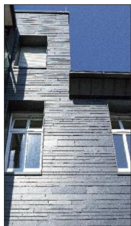
Die Dynamische Deckung aus Schiefer wurde in Meinerzhagen in vier unterschiedlichen Ansichtshöhen verbaut.
