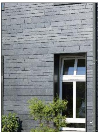
Die Dynamische Deckung aus Schiefer wurde in Meinerzhagen in vier unterschiedlichen Ansichtshöhen verbaut.
